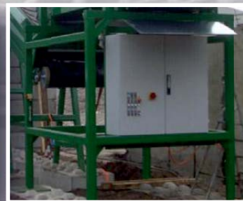
quadro di comando/PLC
